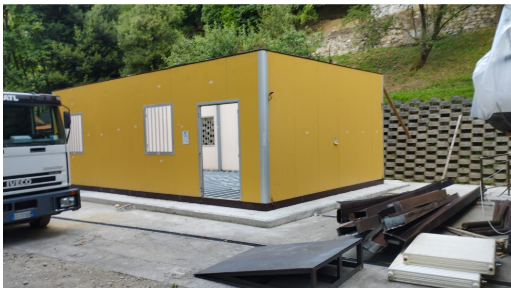
Allestimento nuovi magazzini
