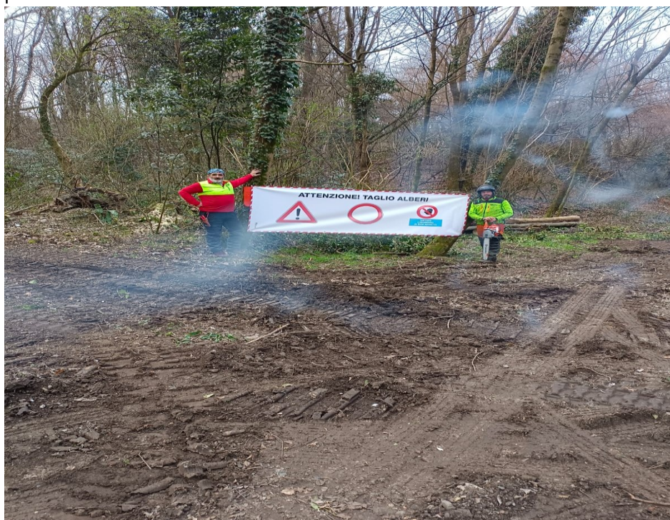
Inizio lavori nel bosco del San Martino
